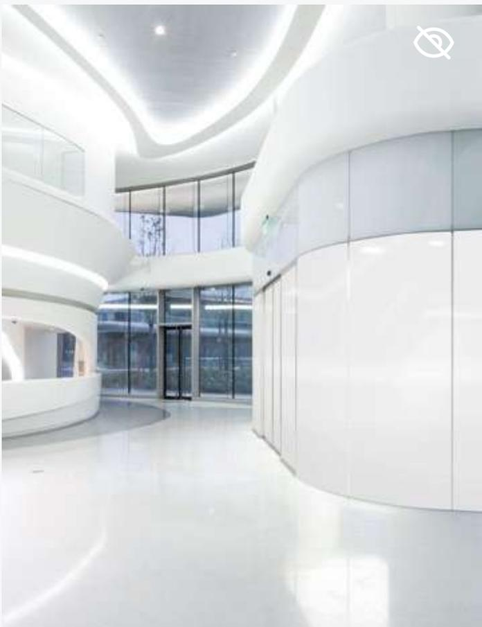
La tecnologia di VK Design non pone limiti alla curvatura dei vetri, resi resistenti alla flessione grazie ad un processo di riscaldamento e ad un successivo lentissimo raffreddamento.
